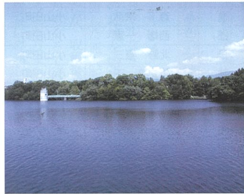
世界かんがい施設遺産に登録された寺ヶ池
