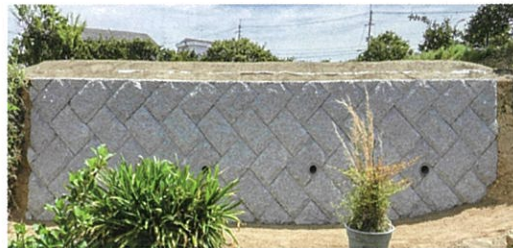
(復旧後) 天野地区
