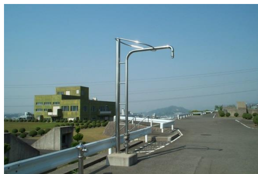
緊急給水拠点の給水塔
