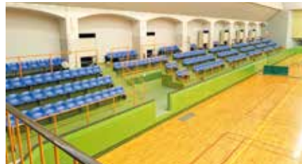
空調機設置、試験稼働中
