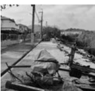
ほぼ仮復旧が完成した崩落現場
