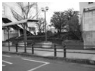
設計済みとなっている 南海千代田駅西口のトイレ予定地
