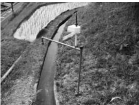
スマート農業の一環として、水路に水位センサーを設置した実証実験が開始
