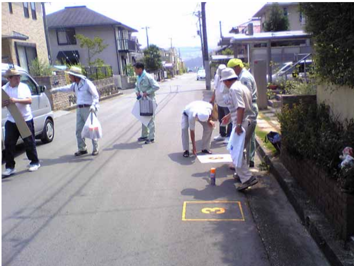
□楠ヶ丘乗合タクシー停留所の設置の様子
