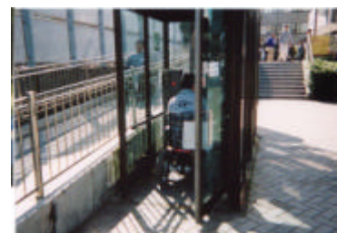
1-4 駅前広場の公衆電話 電動車椅子では扉が閉まらない。
