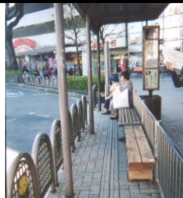
7-5 バス停通路の障害物 ベンチ、柱、柵がバリアになっている。
