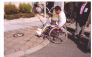
2-4 道の急な切り下げ 切り下げが急で、歩道にさがれない。
