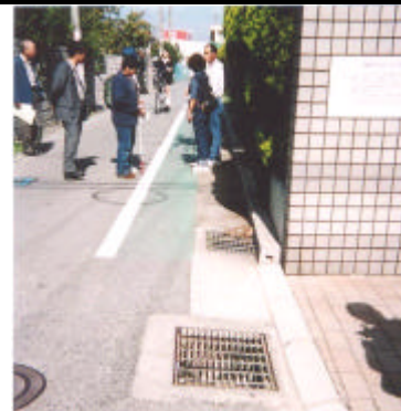
3-4 目の粗いグレーチング 目が粗いために、白杖の先が 落ち込んでしまう。
