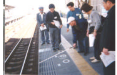
4-1 ホームの警告ブロック
