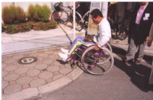
道の急な切り下げ 切り下げが急で、歩道にあがれない
