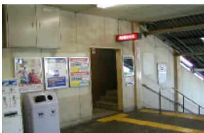
写真3 車いすの利用が難しいトイレ
