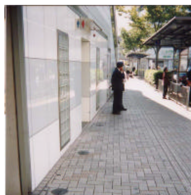
トイレ入口へ誘導ブロックが未整備 誘導ブロックが連続していない
