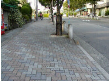
F.西代2号線 誘導ブロックの未整備
