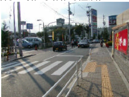
k.野作台4号線 連続した誘導ブロックの改善
