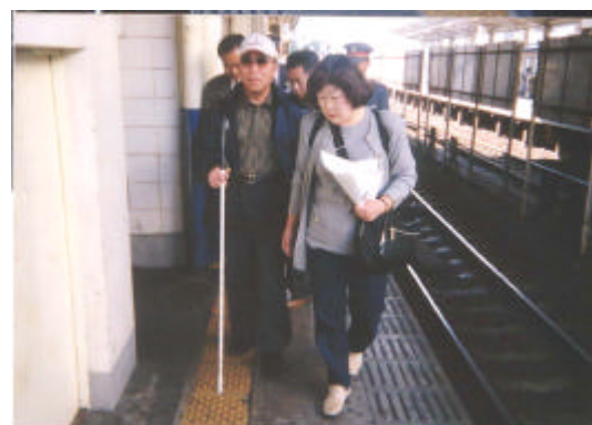
ホームの幅が狭い ホームの幅が狭く転落の危険性がある
