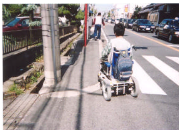
歩道幅員不足の道路 歩道幅員が不足しており、安全確保ができない
