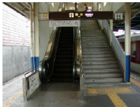
写真2 改札からホームへのエスカレーター
