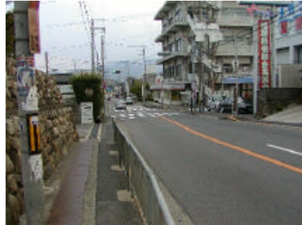
B.国道310号 有効幅員の不足している両側歩道
