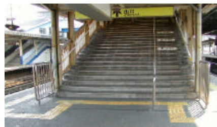
写真2 改札からホームへの段差（階段）
