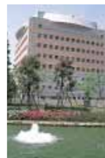
新庁舎完成 (63年)
