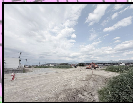
9街区 盛土工事
