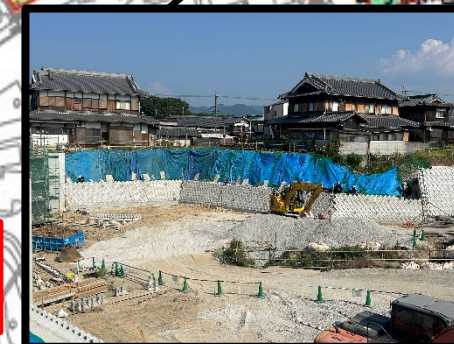
調整池 ブロック積擁壁切土・石積工
