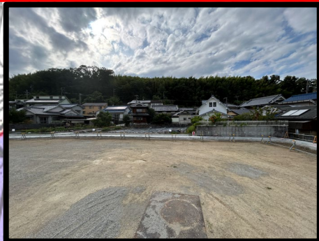
11・12街区 境界フェンス基礎・用水路工
