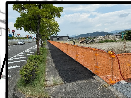
4街区 R170擁壁撤去 ～歩道拡幅工事
