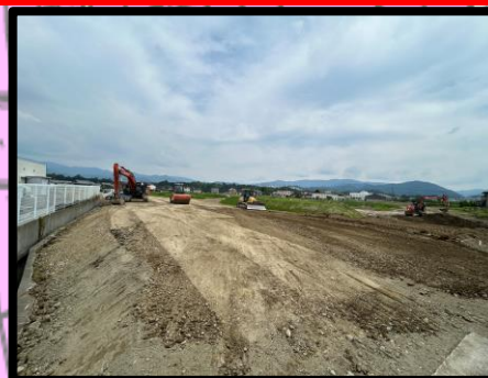
9街区 盛土工事
