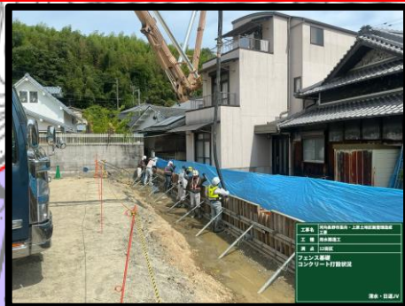
12街区 境界フェンス基礎・用水路工
