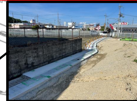
17街区 境界フェンス基礎・用水路工
