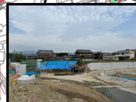
区画道路4・5号線 雨水・污水排水、水道工事完了
