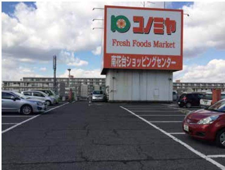
▲ コノミヤ南花台店の屋上は普段は駐車場として使われている
