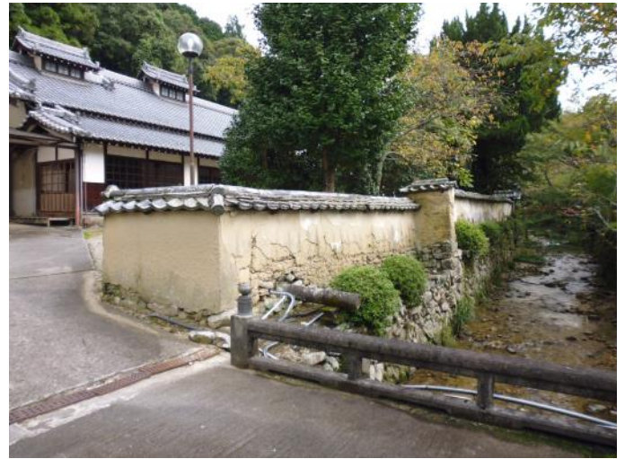
金剛寺 天野川東岸子院築地塀
