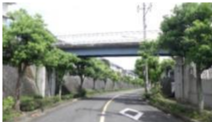
美加の台 2号歩道橋 (美加の台 2丁目付近)
