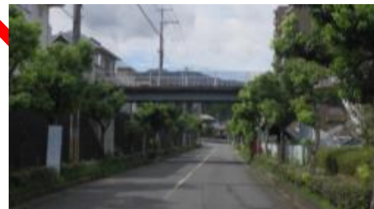
美加の台 3号歩道橋 (美加の台 7丁目付近)
