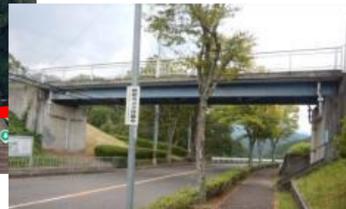
美加の台 4号歩道橋 (美加の台 4丁目付近)
