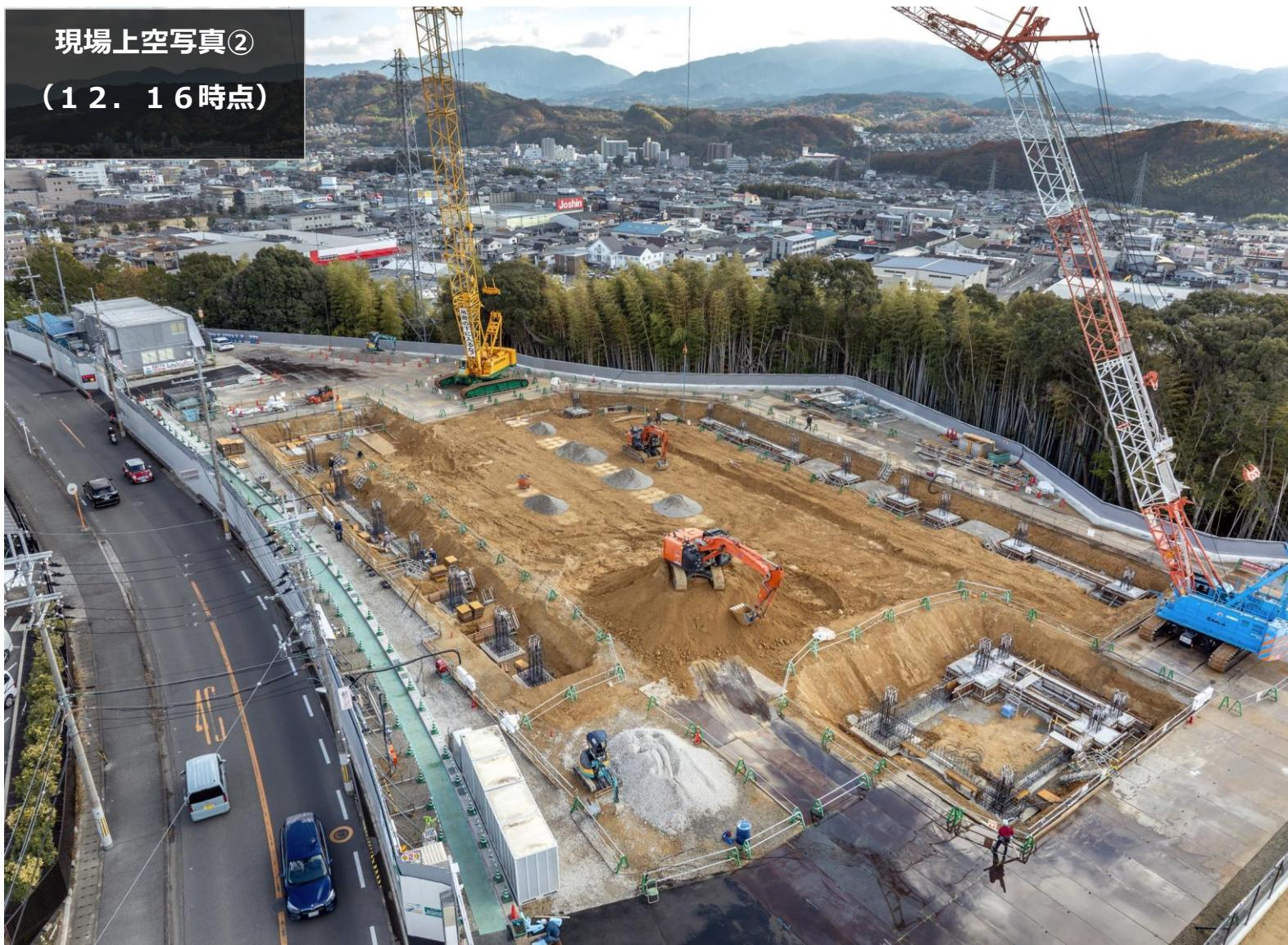
建築物を建てる範囲において地盤を強化するための柱状改良工事が完了し、基礎工事に着手しました。
