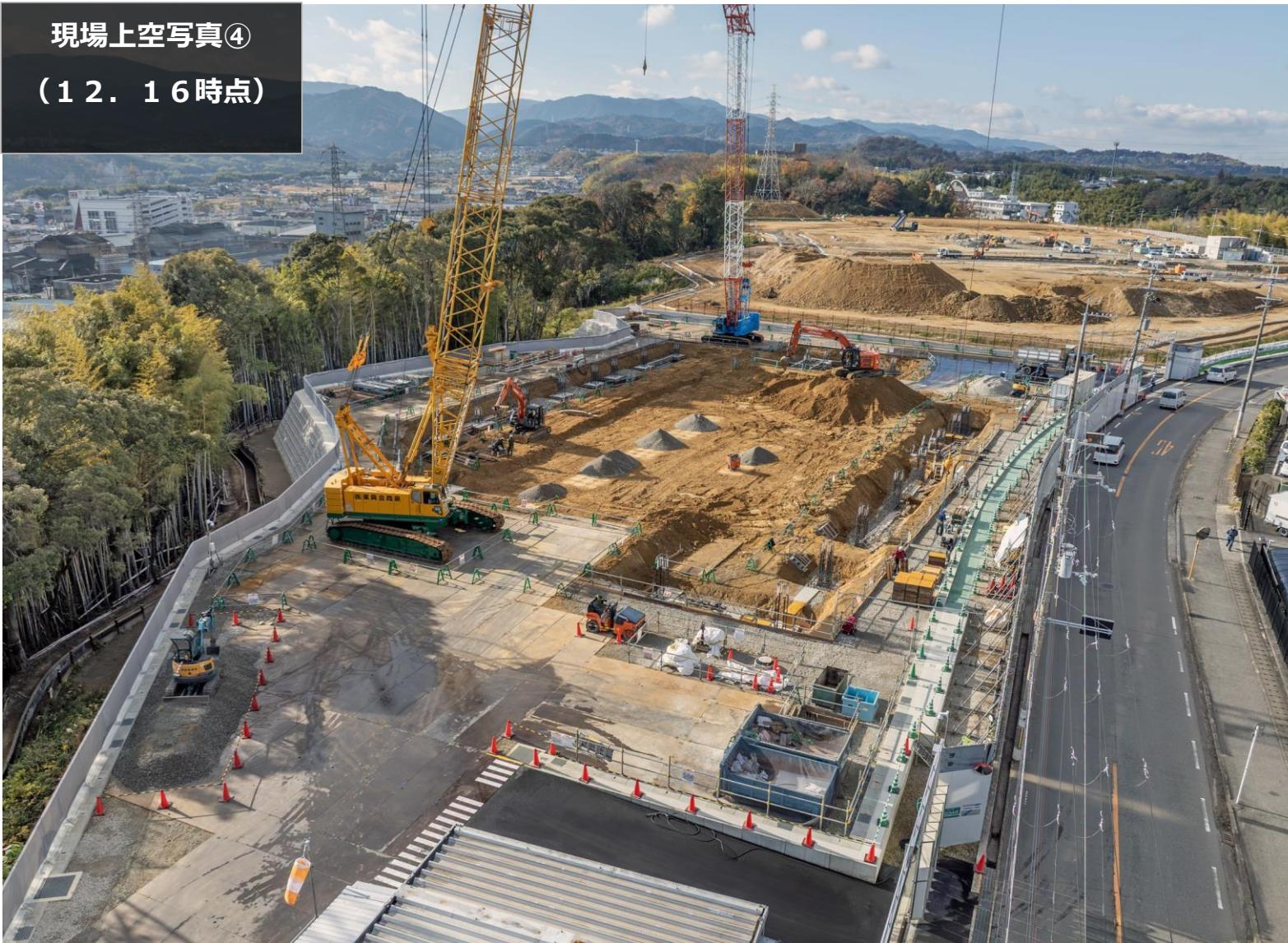
その他の工区については、根切り(基礎を作るため地盤を掘削する土工事)を進めています。
