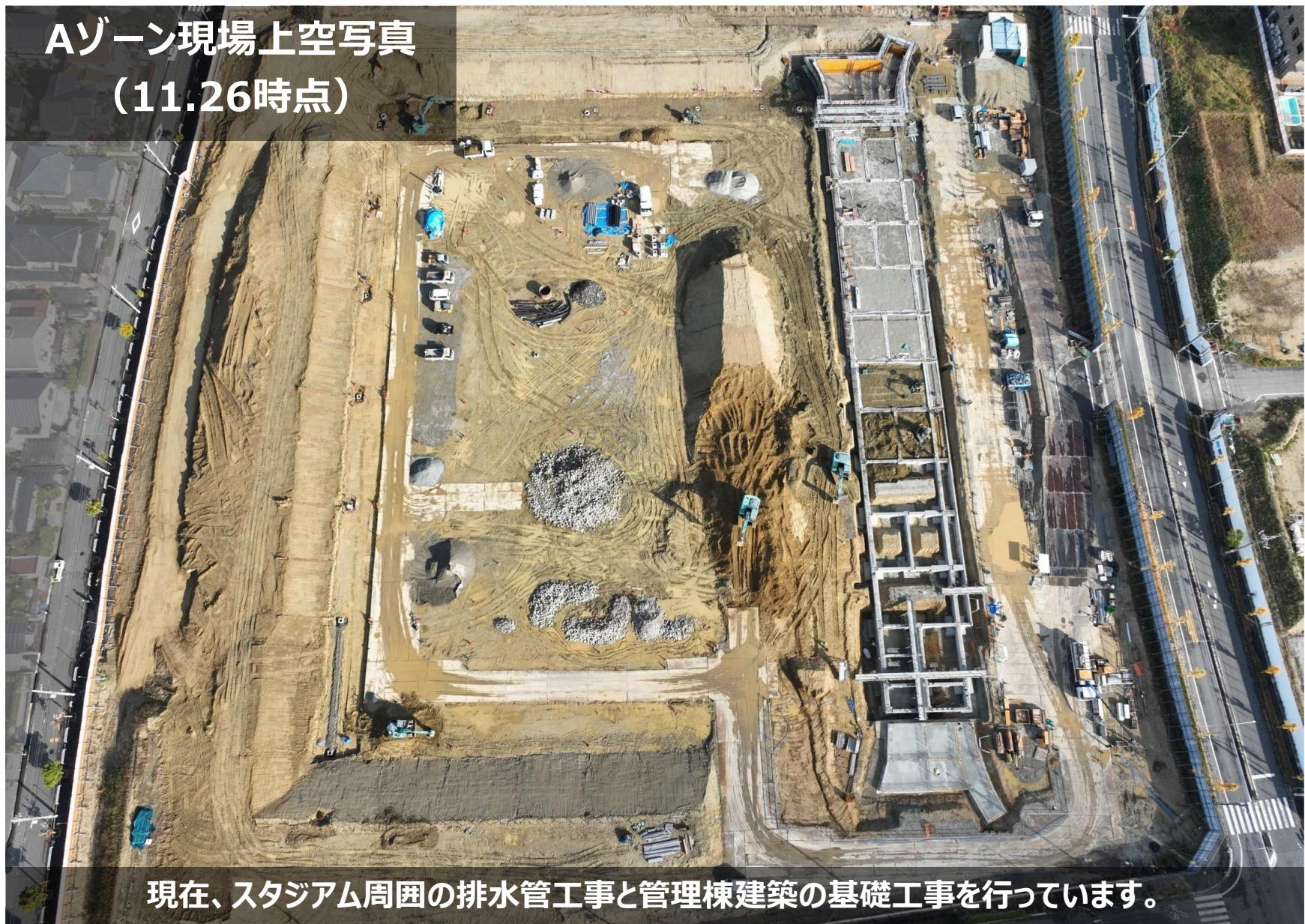
現在、スタジアム周囲の排水管工事と管理棟建築の基礎工事を行っています。
