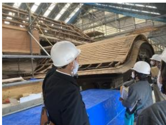
第47図 建造物の修理の様子
