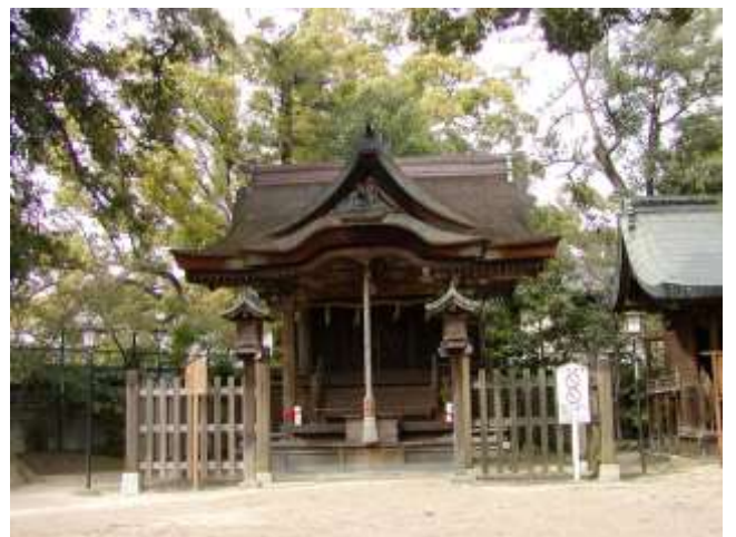
第26図 重要文化財 長野神社本殿
