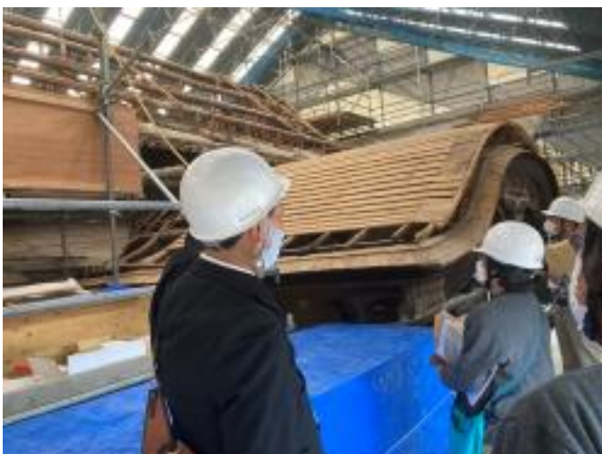
第47図 建造物の修理の様子
