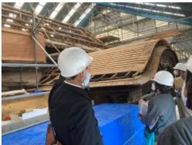
第47図 建造物の修理の様子
