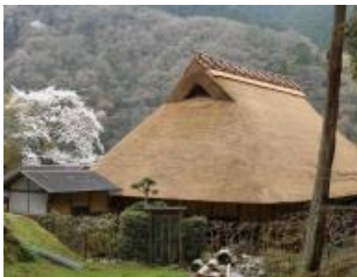
第27図 重要文化財 山本家住宅
