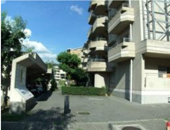
市営桜ヶ丘住宅
