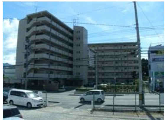
市営三日市西住宅
