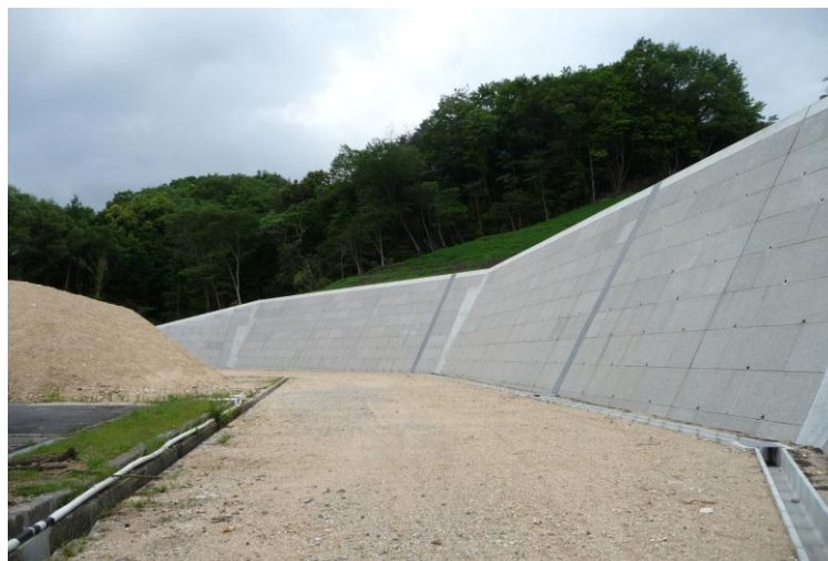
市営斎場 大型ブロック積擁壁の写真（平成 26 年 6 月撮影）
