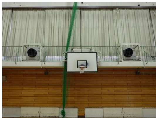
体育館空調整備事業
