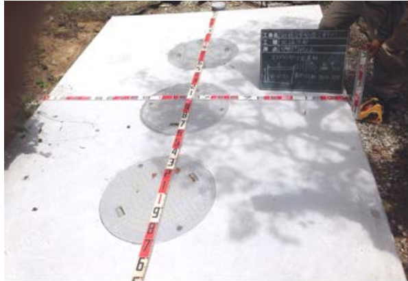
写真 5.1 公共浄化槽の据付後
