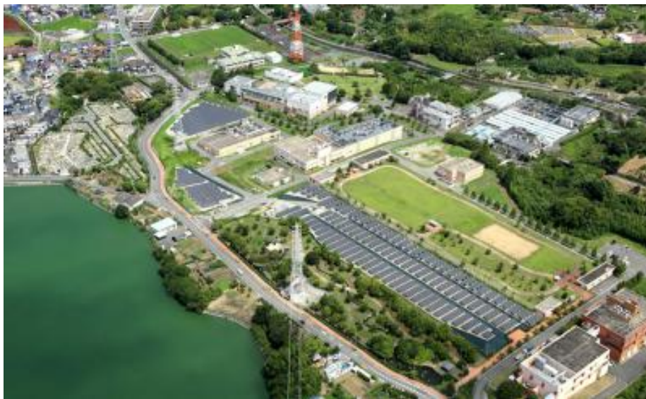
写真 1.2 狭山水みらいセンター：大阪府 HP より
