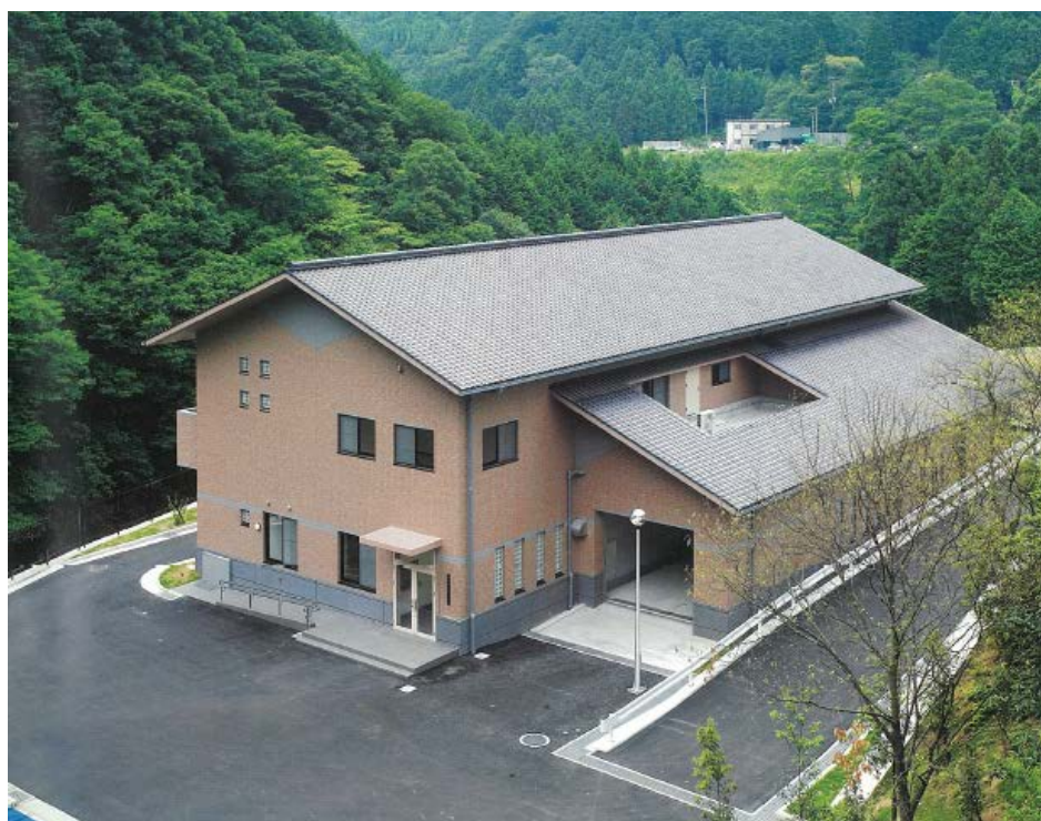
写真 1.3 滝畑浄化センター：パンフレットより
