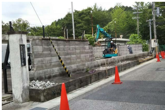
写真 2.3 ブロック塀の撤去工事
