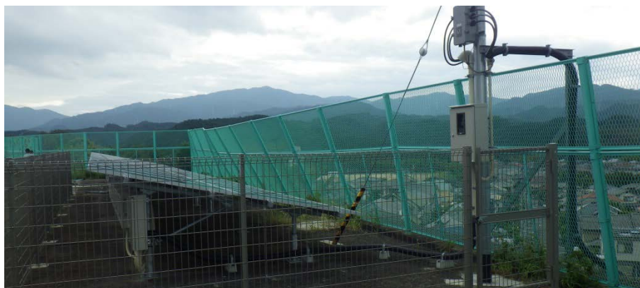
写真 2.6 風による東部第3配水池のフェンスの変形
