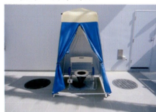
マンホールトイレ
