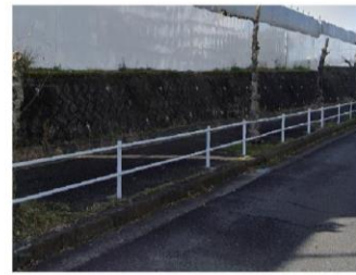
既設柵は再塗装
