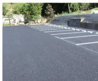
密粒アスファルト舗装
