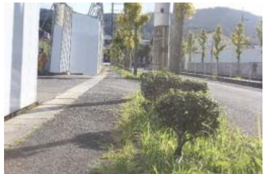
▲南花台1号線沿いの歩道状況
