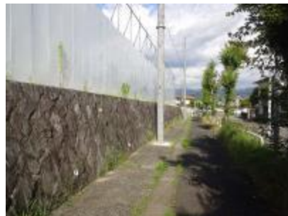
▲Bゾーン南側の擁壁
