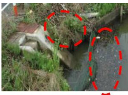
土砂、ゴミ等による取水阻害
