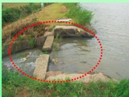
⑦ 洪水吐の堰上げ
