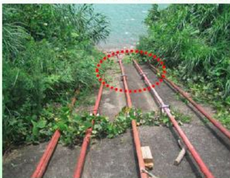
⑤ 斜樋の破損(スピンドル挫屈)
