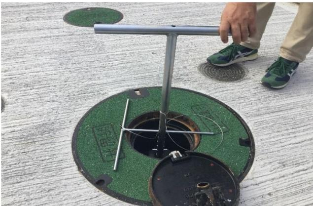
貯留弁内に専用器具が落ちないように固定すると排水が行われます。管内の排水が完了したら専用器具を外し、貯留弁に蓋をします。
