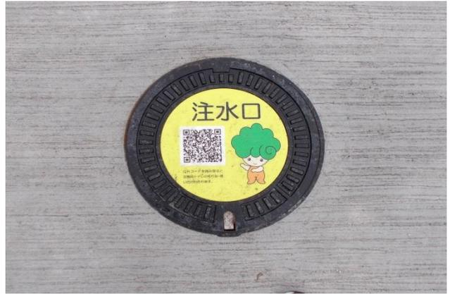
排水完了後、「注水口」の文字がある蓋を専用パールで開け、可搬式緊急送水ユニットを使用して注水を行う。
