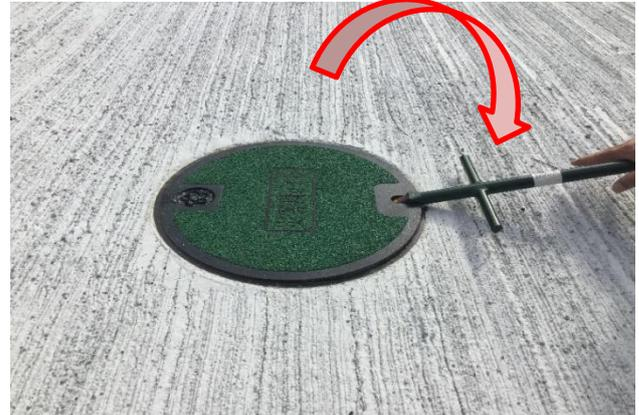
専用ボールを下方向に動かし、蓋を浮かせる
