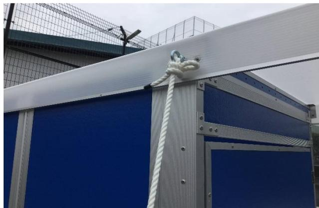
屋根固定ボルトとアイボルトをロープで結び（4ヶ所）上屋を固定する
