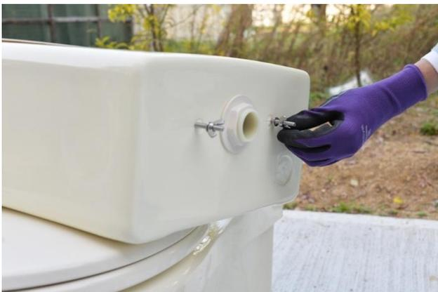
ロータンク部の裏面の蝶ネジを使用し、便器と接続する
