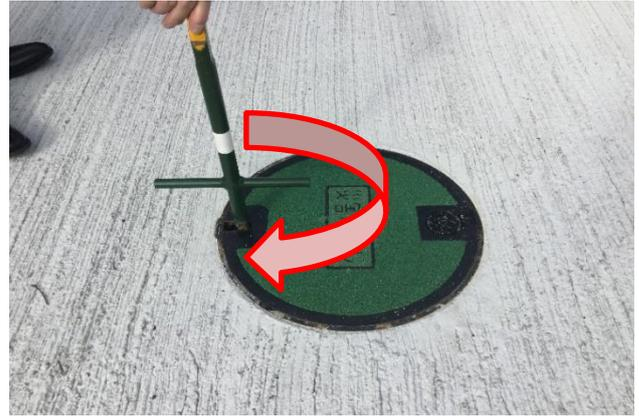
マンホール蓋のロック部に専用ボールを差し込み、専用ボールを90°回す
