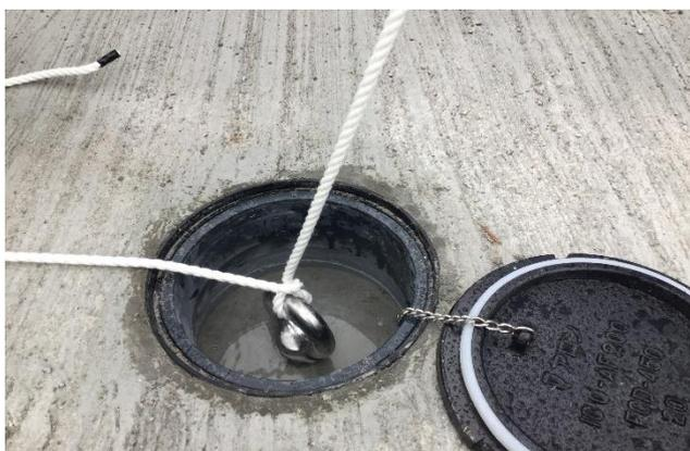
アイボルト部分は、アンギラスを使用し、てこの原理で蓋を開ける
