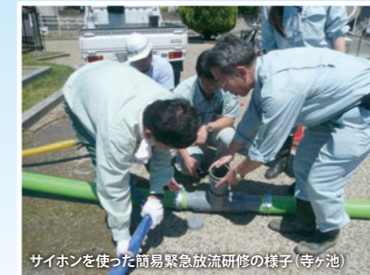
サイホンを使った簡易緊急放流研修の様子(寺ヶ池)
