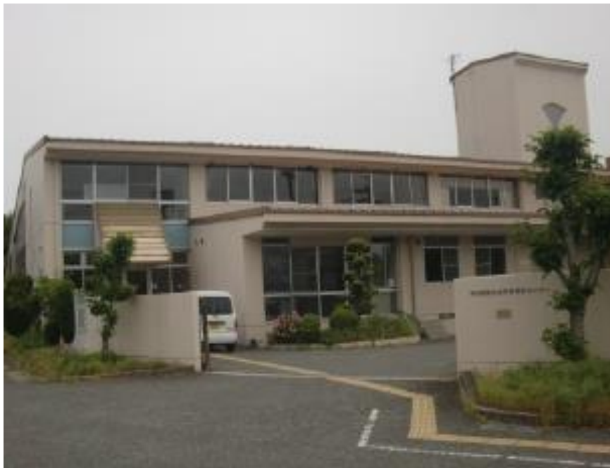
写真 1-3：現学校給食センター外観
