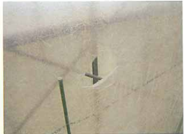
写真－10 内張カーテンの破れ2
