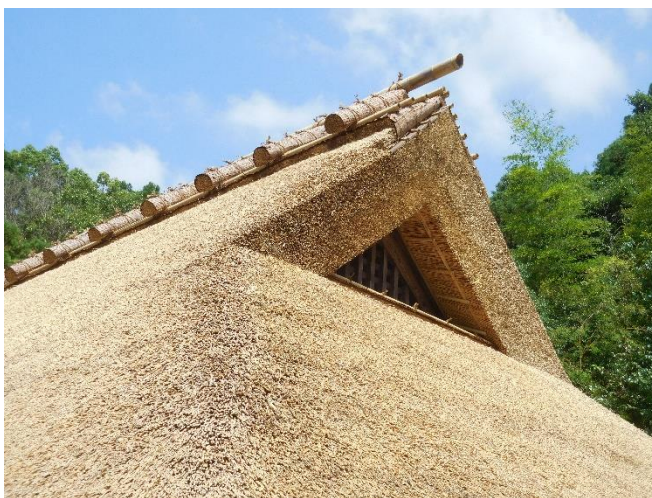
竣工（屋根妻）外観
