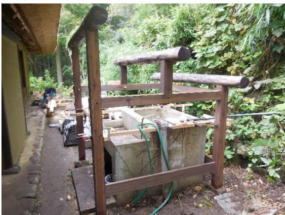
水屋軸部組立状況
