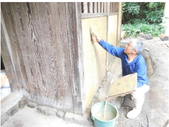
外部中塗壁補修中
