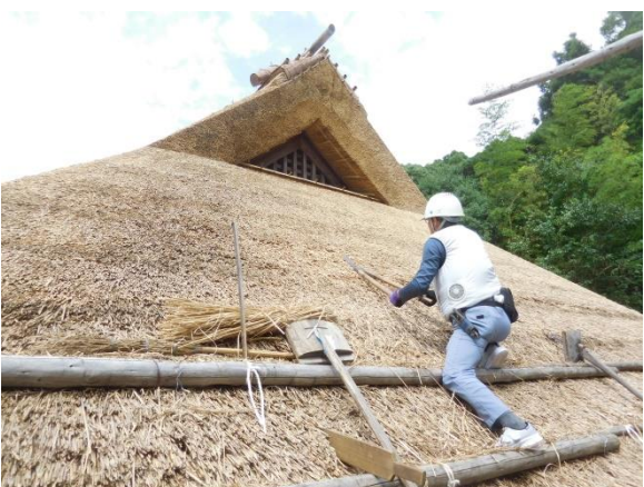
屋根妻側刈り込み施工中
