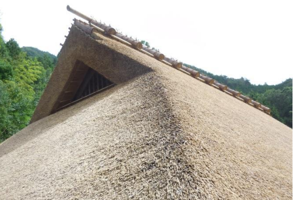
屋根妻側刈り込み状況
