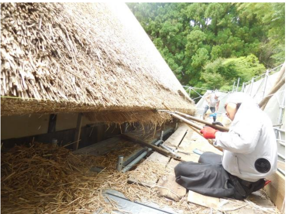
屋根軒積刈り込み施工中
