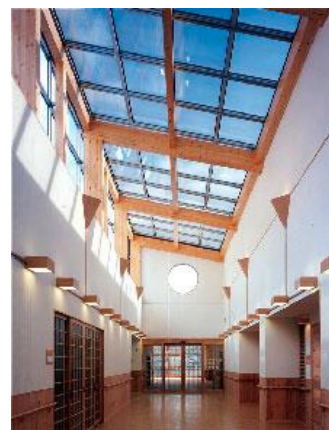
■太陽光発電シースルー パネル(くすのかホール)
