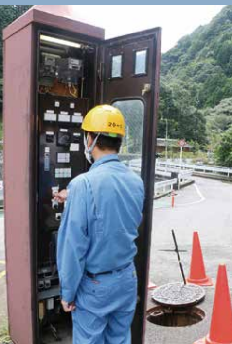
▲マンホールポンプ場点検の様子
