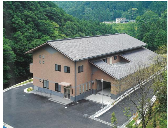
写真 滝畑浄化センター (平成 14 年度供用開始)
