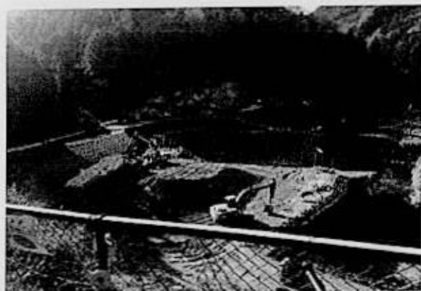
(371号バイパス天見島の谷地区の工事)
