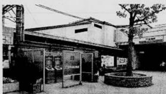
たばこ産業などの寄付で設置された 金剛駅の喫煙所
