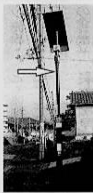
国道310号線 街灯(原町)
