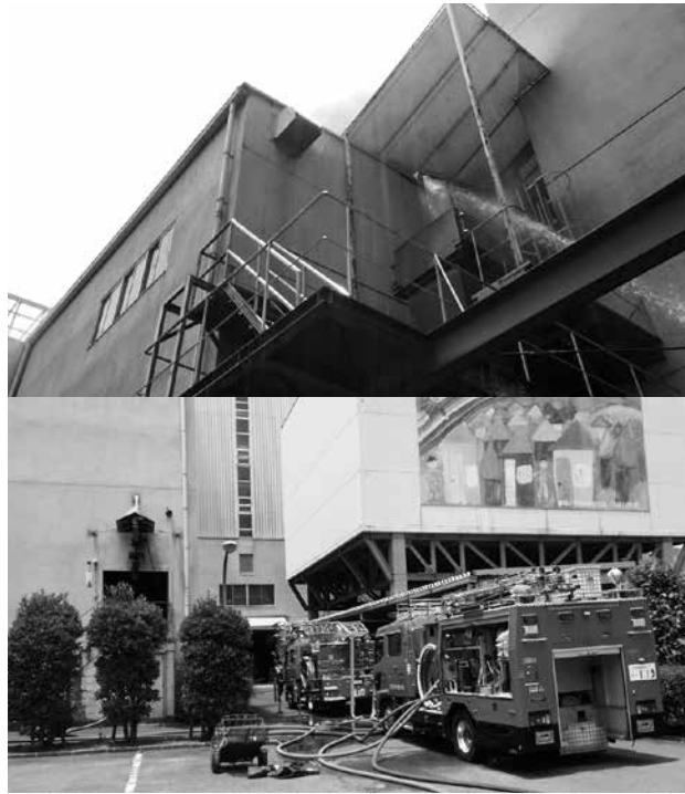
煙が上がる清掃工場と、消火の様子
