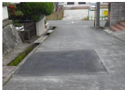
復旧完了状況
