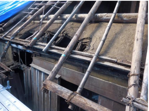
雨漏れによる各部の破損状況
