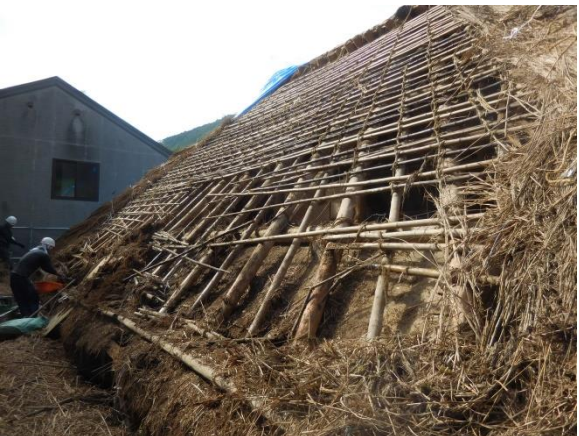
茅葺屋根の解体状況
