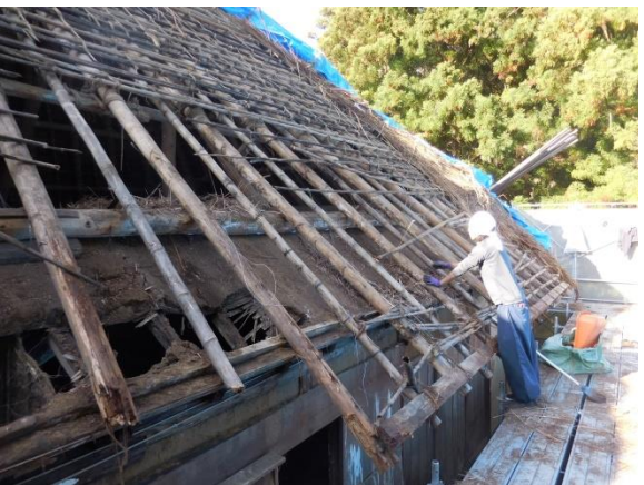
茅葺屋根の下地解体状況
