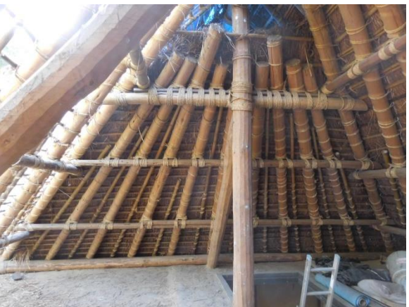
小屋裏より見る屋根下地状況
