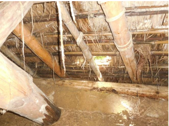
雨漏れによる土置天井の破損状況
