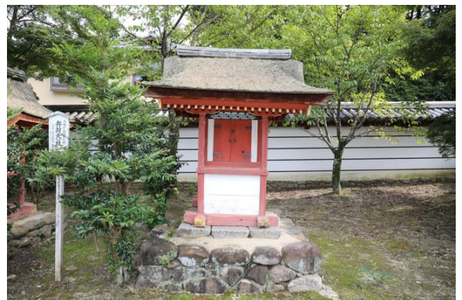
金剛寺 弁財天社本殿
