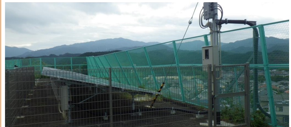
東部第3配水池(清見台)フェンス被災状況
