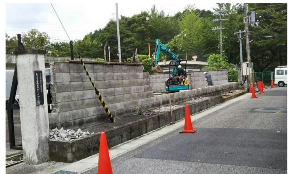
ブロック塀撤去状況(南青葉台ポンプ室)
