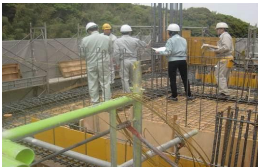
（工事中間検査風景）
